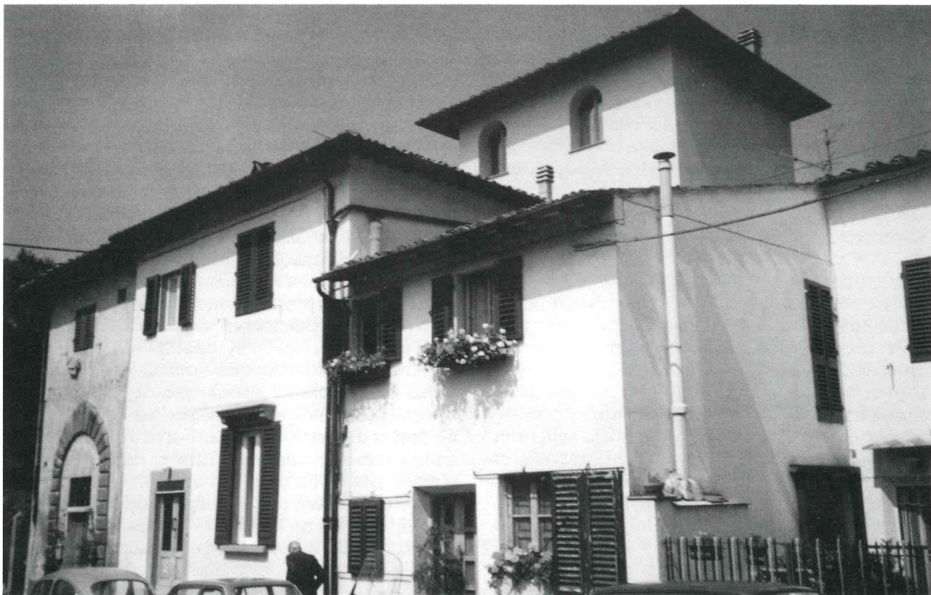
L'attuale aspetto della villa di Querceto che nel XVIII secolo appartenne ai Riccardi. Il portale rinascimentale, contornato da bozze di pietra e i peducci delle volte del portico, ormai da tempo demolito, che tuttora si vedono sulla parete di fianco, volta a sud, dell'edificio di via di Querceto distinto dai numeri civici 131, 133 e 135, rappresentano quanto resta dell'antica villa dei Riccardi.
