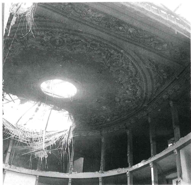
Il controsoffitto del teatro Niccolini, decorato con le immagini dei drammaturghi italiani, fotografato al momento della demolizione (1964).
