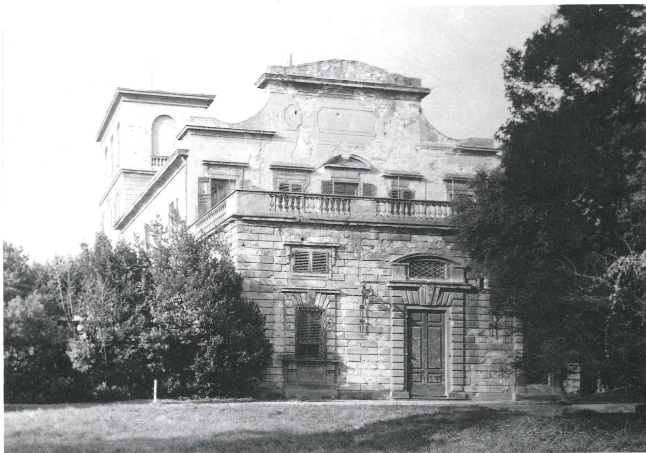
Facciata principale della villa (lato Sud/Est).
