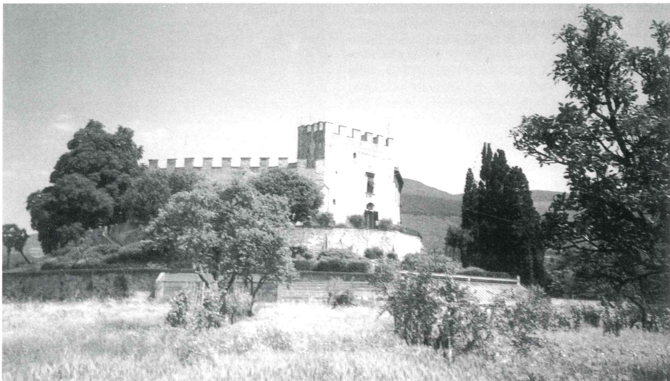
La villa «la Mula» a Quinto. Nella costruzione, a pianta poligonale, appare evidenziata la struttura della torre medievale scapezzata dell'antico palagio dei Della Tosa.
