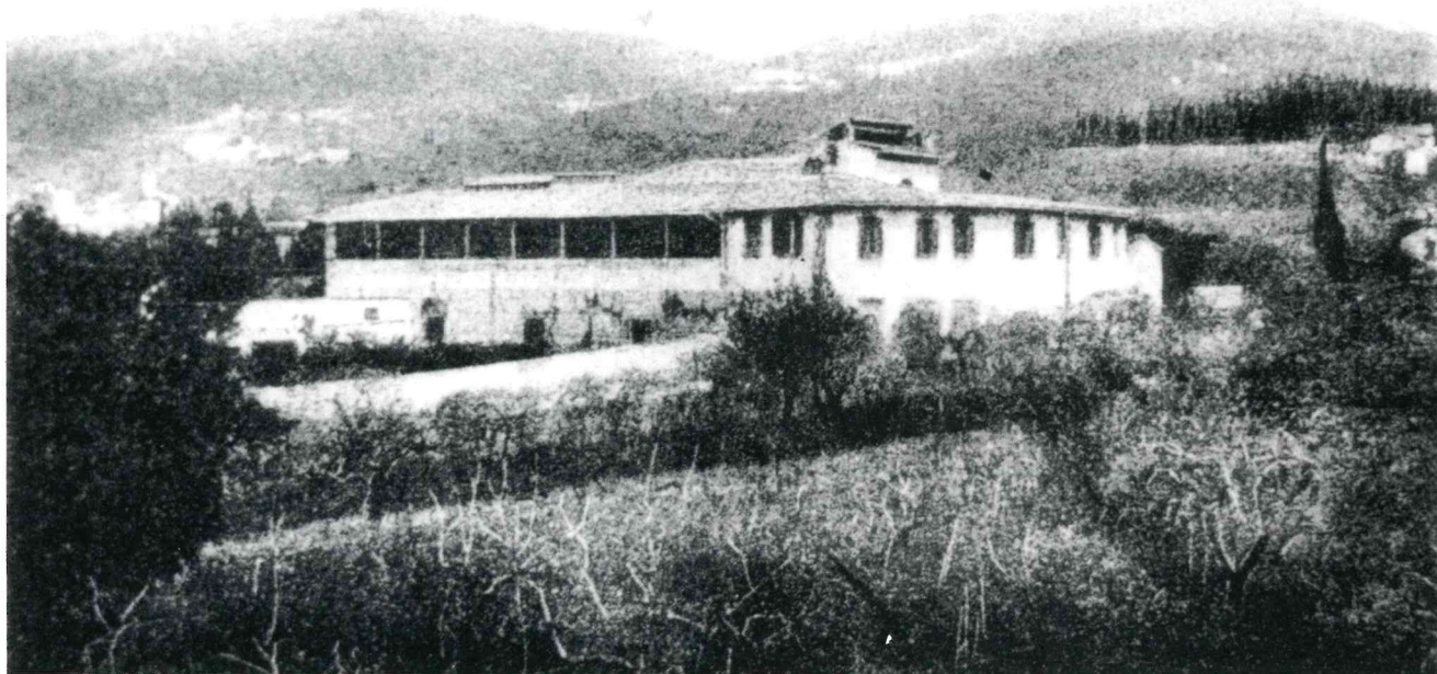
Villa «Il Prato alla Tosa», proprietà Villorresi, in una foto dei primi del nostro secolo. Dominante, al di sopra della copertura dell'edificio, la caratteristica colombaia nella quale la falda più alta del tetto si soprammette a quella inferiore creando uno spazio riparato che rimane aperto. Corrispondente presumibilmente alla utilizzazione quattro-cinquecentesca di una torre scapezzata di epoca medievale.
